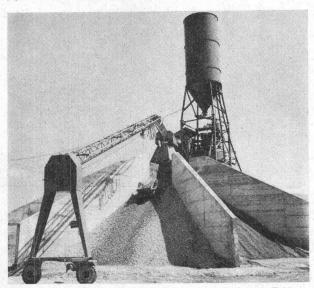
Zwangsmischer Raco-von Roll 750 I, Automatik-Schrapper Zyklos, Pfister-Kieswaage mit Fernanzeige, Frischbeton-Vorsilo 3,5 m³ für Lastwagenbeschickung (Gravière de Courroux SA, Courroux)
