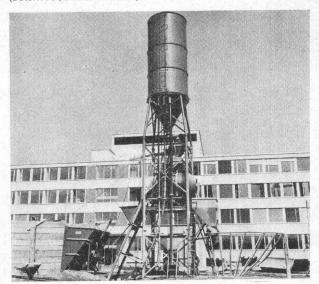
Reversiermischer Raco-von Roll 670 I, Zementsilo 30 t mit separatem Entnahmerohr, Frischbeton-Vorsilo 1,6 m³, Fangkorb (Ed. Züblin+Cie. AG, Zürich)
