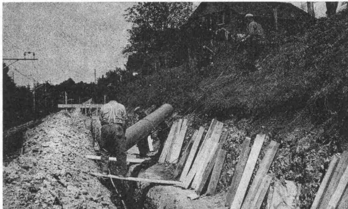
KALIDUR-Kanalisationsrohre, verlegt im Bahneinschnitt
