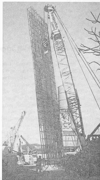
Bild 19. Versetzen einer Armierung
