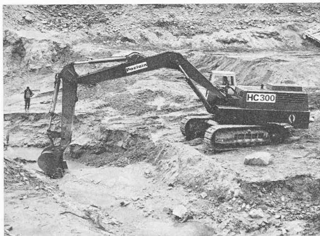
Bild 1. Der Hydraulikbagger Poclair HC 300 im Einsatz
