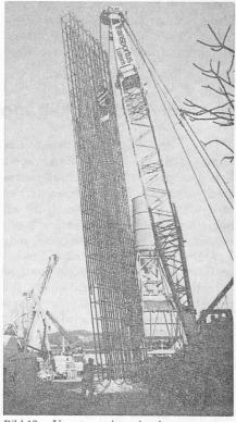
Bild 19. Versetzen einer Armierung
