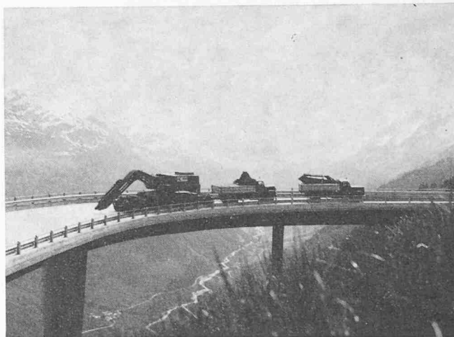
Bild 2. Der Bagger wird in einem Transport von Airolo zur Gotthard-Passhöhe gefahren
