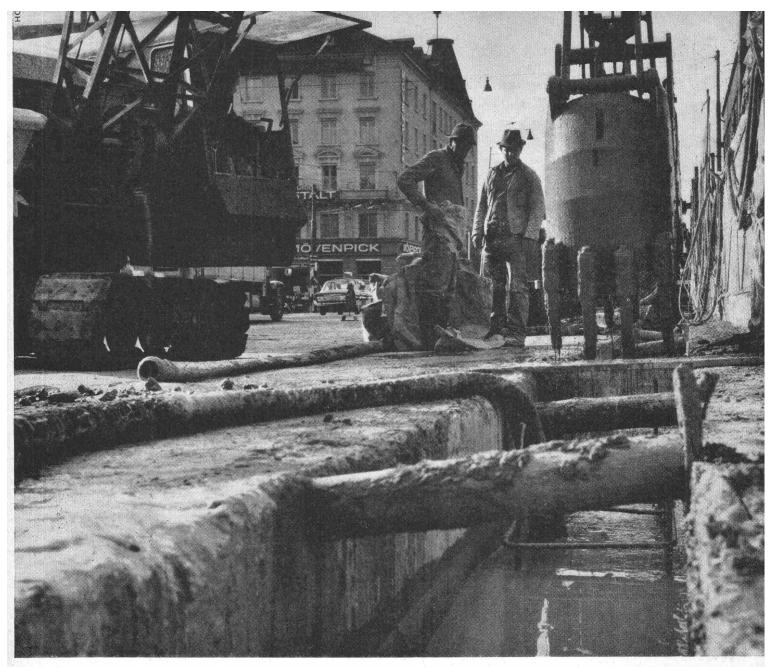
Schlitzwände im Bentonitverfahren für Baugrubenumschliessungen. Öldichte Tauchwände zum Schutz des Grundwassers. Stützmauern im T-Profil. Unverrohrt gebohrte Pfähle grosser Tragkraft und Tiefe. Lärm- und vibrationsarm.
