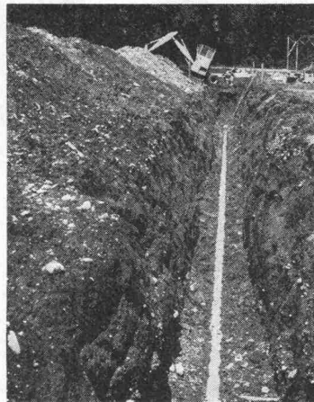
Graben für eine Rohrleitung
