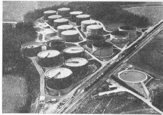
zuflüssen von aussen. Ein grosses Flutungs- und Löschwasserbecken weist einen Nutzinhalt von 2700 m³ auf, ein kleinerer Behälter für Löschwasser einen solchen von 400 m³ und als letzte Reserve kommt der Ölabscheider mit einem Inhalt von knapp 1000 m³ in Frage. Zusätzlich besteht die Möglichkeit, den neben der Anlage vorbeifliessenden Bach aufzustauen.
