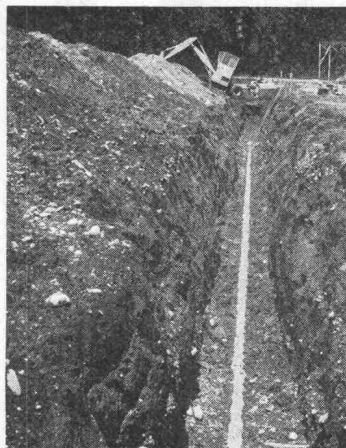
Graben für eine Rohrleitung
