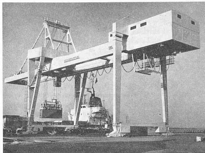
Bild 1. Ansicht des 30-t-Container-Umschlagkranes im Hafen von Harwich
