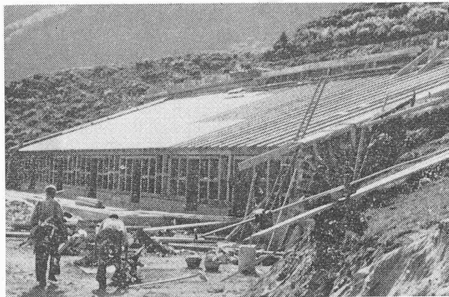
Bild 3. Alpstall Malschüel Mittelsäss, auf 1620 m ü. M., Gemeinde Sevelen, Besitzer: Ortsgemeinde Buchs, für 100 Grossvieheinheiten mit Hirtenhütte, erbaut 1952/53; Baukosten 145 000 Fr. Da sich der Standort in einem Lawinenhang befindet, wurde eine Pultdachkonstruktion gewählt; der Normstall wäre hier ungeeignet
