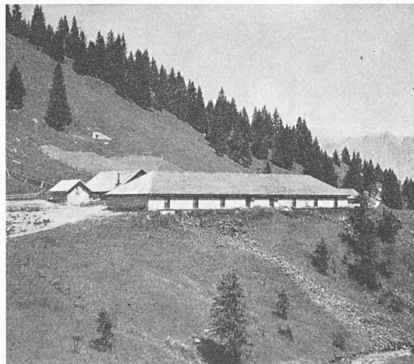
Bild 1. Querstall auf Alp Kohlschlag Untersäss, Gemeinde Mels, für 160 Grossvieheinheiten, erbaut 1893/94; Baukosten 13 000 Fr.
