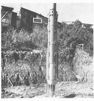
Bild 2. Torpedo-Rüttler mit Traggerät
