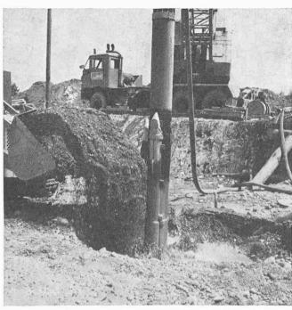
Lagerungsdichte aufweist, denn in locker gelagerten Zonen ist der Verdichtungseffekt natürlich sehr viel grösser als in bereits dichter gelagerten Zonen. Der Wirkungsbereich eines Rüttelpunktes hängt stark von der Bodenart ab und liegt im Maximum bei etwa 6 m². Es ist zudem darauf zu achten, dass wirklich eine Vergrösserung der Verdichtungsfläche gegenüber der Fundamentfläche stattfindet (Bild 6).
