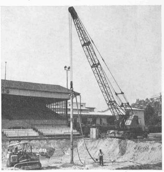
Bild 3. Verdichtungsvorgang beim patentierten Rütteldruckverfahren
