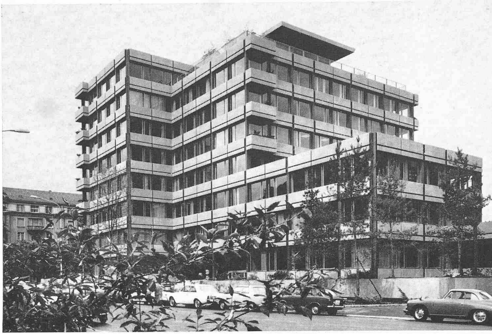
Westfassade an der Alfred-Escher-Strasse
