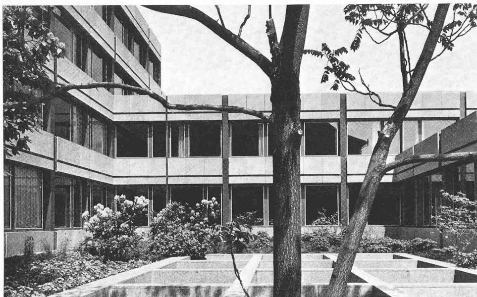
Hofpartie in der Eingangszone mit offenem Rippenraster über dem Parkgeschoss (erstes Untergeschoss)
