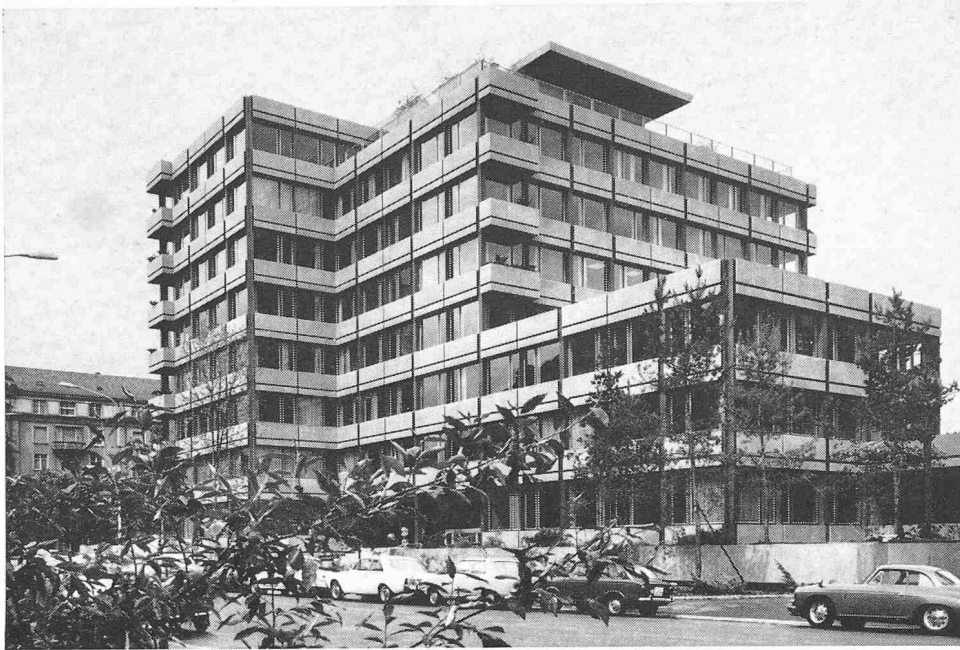
Westfassade an der Alfred-Escher-Strasse
