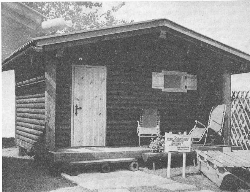
Bild 4. Wochenendhaus, gebaut unter weitgehender Anwendung von RUHO-Elementen
