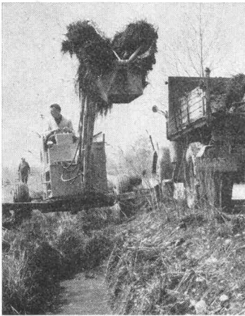
Arbeit mit dem Grabenlöffel
