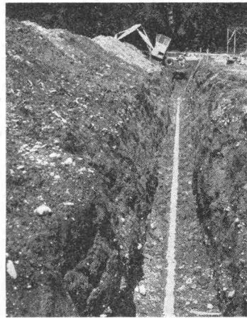
Graben für eine Rohrleitung
