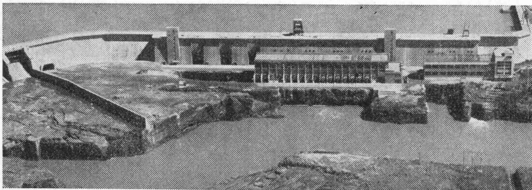
Kraftwerk Cachoeira Dourada, Brasilien
