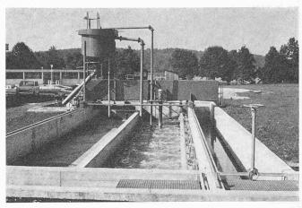
Bild 16. Belüfteter Sandfang (Kläranlage Langenthal)
