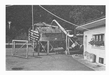
Bild 28. Kammerfilterpresse zur Schlammentwässerung (Kläranlage Wädenswil)
