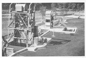
Bild 14. Greiferrechen (Kläranlage Illnau-Effretikon)
