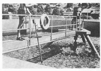
Bild 18. Belüftungsbecken mit zentralsymmetrischem Oberflächenbelüfter (Kläranlage Wattwil)
