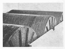
Bild 22. Tauchtropfkörper (Kläranlage Unterwasser)
