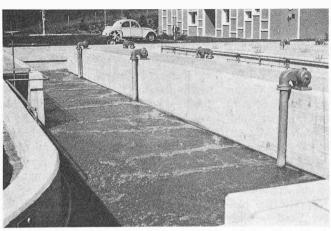
Bild 21. Tropfkörper (Kläranlage Mönthal)
