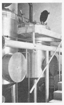
Bild 27. Pasteurisierungsanlage (Kläranlage Illnau-Effretikon)
