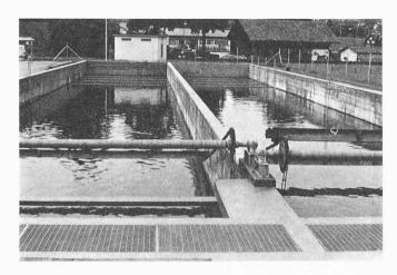
Bild 24. Reaktions- und Absetzbecken der dritten Reinigungsstufe, Nachfällung (Kläranlage Jona)
