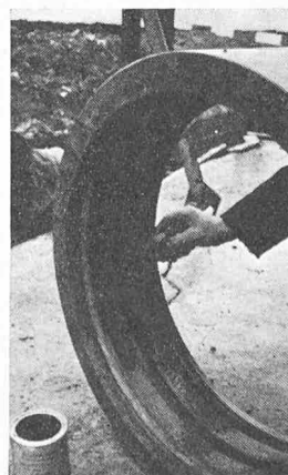
Bild 5. Kupplung eines Asbestzement-Kanalisationsrohres
