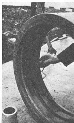
Bild 5. Kupplung eines Asbestzement-Kanalisationsrohres
