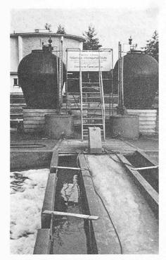
Bild 25. Eisenchloridbehälter für Simultanfällung (Kläranlage Uster)
