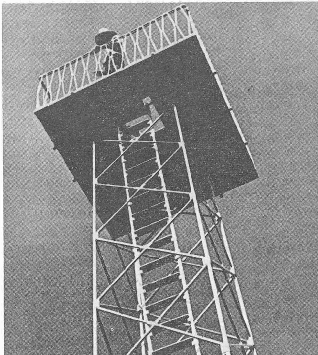
Bild 1. Ansicht des 11,10 m hohen, aus Kunststoff hergestellten Turmes
