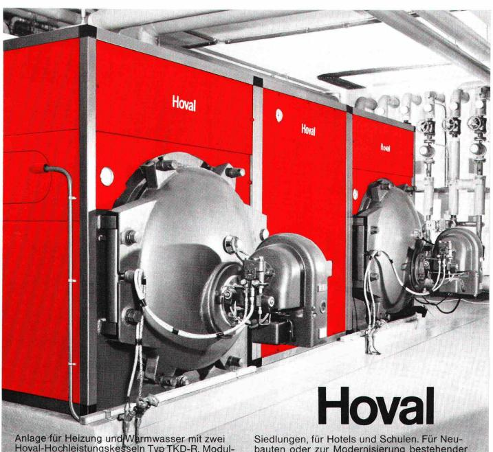
Hoval-Hochleistungskesseln Typ TKD-R, Modul-Boiler zwischen den Kesseln.
