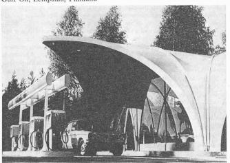
der grösseren Gestaltungsfreiheit für den Architekten. Das geringe Gewicht des verwendeten Kunststoffes (Polyester) vermag die Transportkosten erheblich zu vermindern; zudem bildet ein Bogenelement zugleich Wand und Dach in selbsttragender Konstruktion. Ein Verlegen des ganzen Tankstellengebäudes ist leicht möglich. Wenn dieser Prototyp die Probezeit im Wechsel der nordischen Jahreszeiten gut übersteht, wird er in Serien hergestellt werden.
