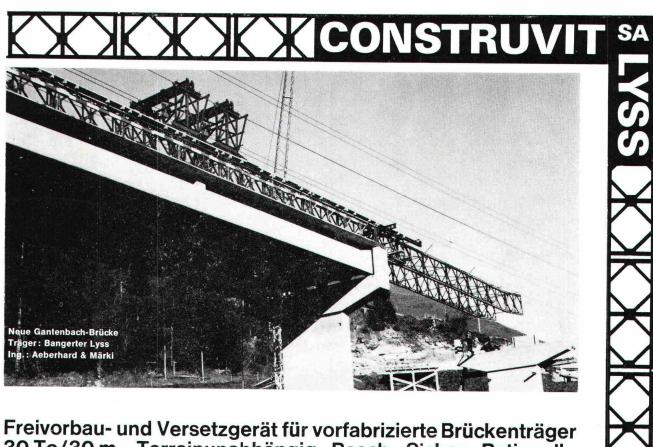
Freivorbau- und Versetzgerät für vorfabrizierte Brückenträger 30 To/30 m - Terrainunabhängig - Rasch - Sicher - Rationell - Günstig - System Bailey - Mietofferten Tel. 032 84 24 05
