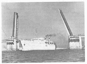
Die meisten Konstruktionsteile stammen aus Deutschland, einige wurden in Spanien hergestellt. Die Montage wurde von der spanischen Firma Dragados y Construcciones unter Leitung deutscher Fachleute durchgeführt. Die Doppelklappbrücke in Cadiz ist eine Weiterentwicklung eines beweglichen Brückentyps, wie er von Rheinstahl bereits im Jahre 1965 in Lübeck über die Trave gebaut wurde.
