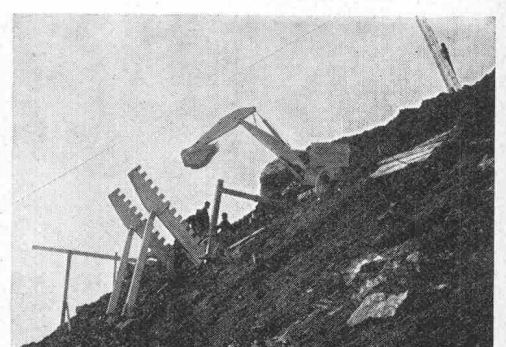
Einsatz bei Lawinerverbauungen
