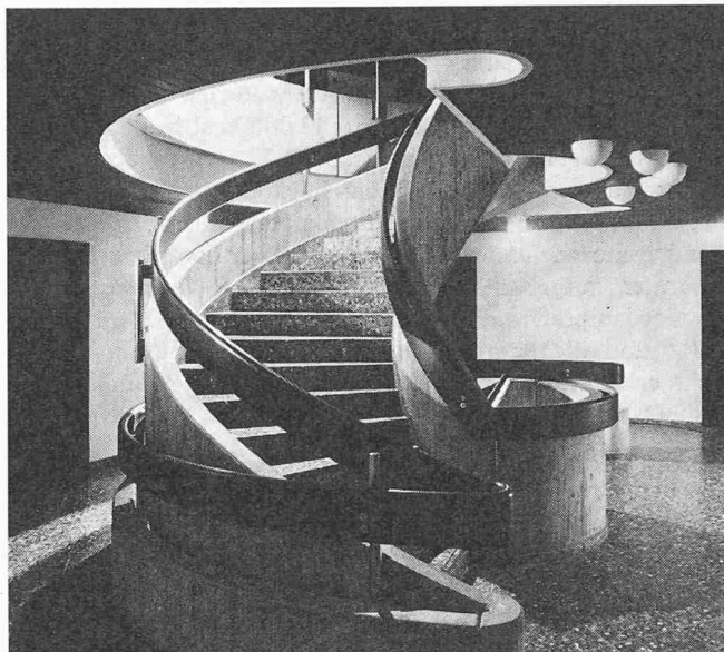
Runde Haupttreppe aus Sichtbeton. Stufen Kunststein, eichener Handlauf. Decke mit Irokoholz verkleidet
