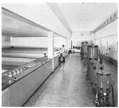
Schnellfilteranlage « Champ-Bougin » der Stadt Neuenburg für das Aufbereiten von Seewasser zu Trinkwasser. Leistung 1800 m<sup>3</sup>/h
