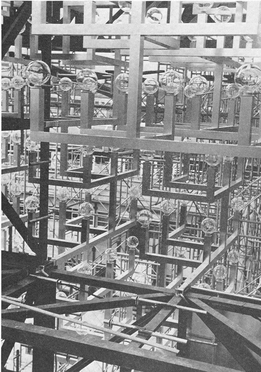
Aluminiumäste, auf die Stahlkonstruktion montiert
