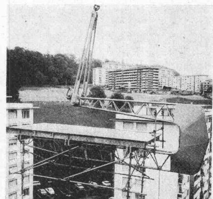
Mit großformatigen NOE-Deckenschal-tischen sowie geeigneten Versetzgeräten ist es möglich, Deckenuntersichten so glatt und planeben zu betonieren, daß nur noch leicht gespachtelt und dann gestrichen oder tapeziert werden kann. Damit wird eine große Einsparung erzielt. Die NOE-Bau-
