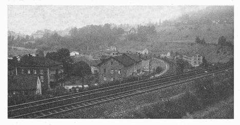
Bild 4. Tiefblick rheinabwärts auf den rechtsufrigen «Landeplatz» der Flurlingerbrücke. Das entscheidende Hindernis der Erstellung eines verkehrsgerechten Anschlusswerks sind die beiden um mehrere Meter gestaffelt übereinanderliegenden Bahnkörper der DB im Vordergrund und der SBB (dieser hier nur an Hand der Signale und Fahrleitungstragwerke erkennbar).
