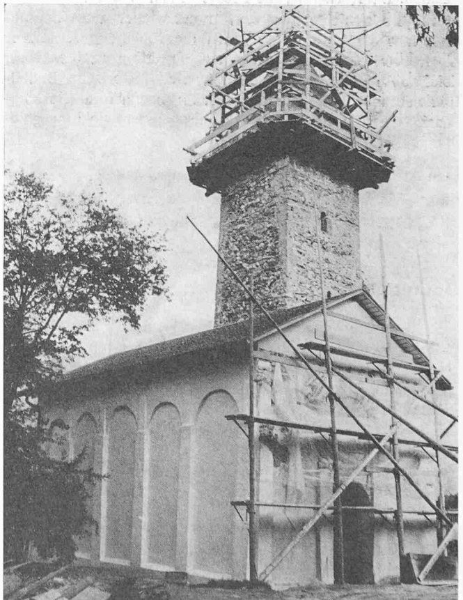
NW-Ansicht St. Martin, Cazis, während der Restaurierung (1968/69)
