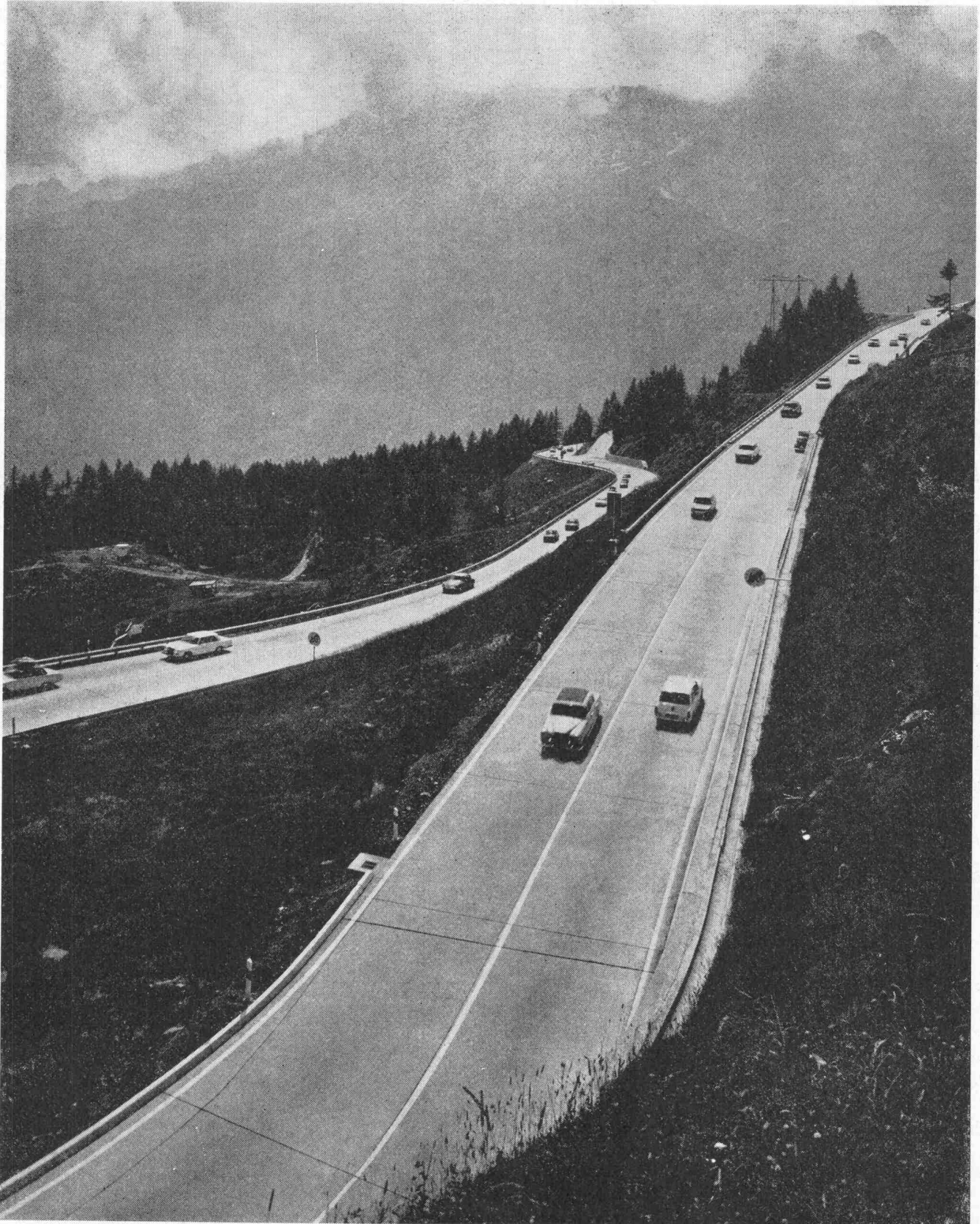
Nationalstrasse N2, Gotthard-Südrampe, Betonbelag
