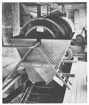
Bild 7. Waschtrommel WA 8 (Pos. 2 in Bild 6)
