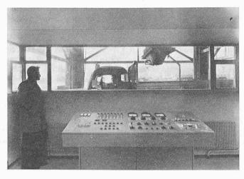
kadenschaltungen können örtliche Materialstauungen vermieden werden, wie sie sich etwa beim Versagen einer Maschine ergeben können. Ferner wurde die Schaltung derart vorgenommen, dass im Falle eines Unterbruches in der Wasserversorgung oder im Abtransoprt des Abwassers sofort alle Maschinen stillgelegt werden. Die gesamte installierte Leistung beträgt im Kieswerk und in den Nebengebäuden rund 2400 PS.
