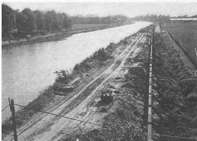
Bild 5. Ausbau des Mittelland-Kanals für das 1350-t-(Europa-) Schiff. Der Boden wasserseitig der Spundwand muss noch gebaggert werden. Für derartig gerade Strecken wurde der Laserstrahl als Rammachse verwendet
