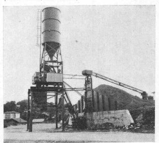
Zwangsmischer Raco-von Roll 750 I, Automatik-Schrapper Zyklos, Pfister-Kieswaage mit Fernanzeige, Frischbeton-Vorsilo 3,5 m³ (Beton Prêt, Châtel-St-Denis)
