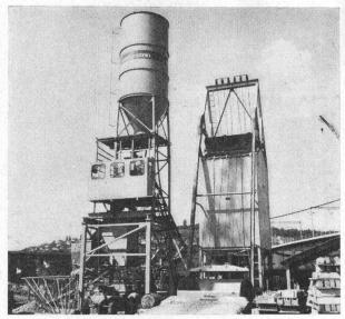
Zwangsmischer Raco-von Roll 750 I, Pfister-Kieswaage mit Fernanzeige, 2 Frischbeton-Vorsilos von 1,6 m³ und 3,5 m³, Fangkorb (Spaltenstein+Co., Zürich)
