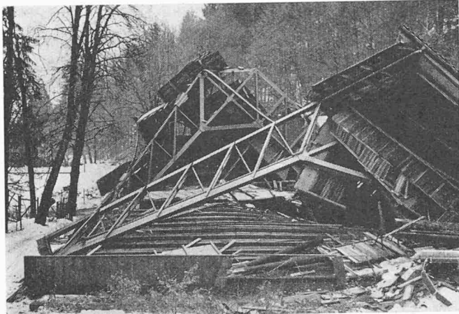
Bild 1. Das alte Tribürendach nach dem Einsturz
