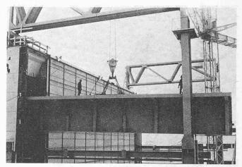
Bild 10. Anschluss der Hauptkranbahn bei der Montage
