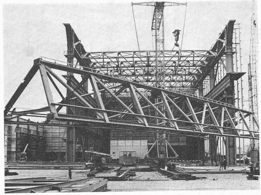
Bild 13. Abheben eines Shedträgers vom Boden
