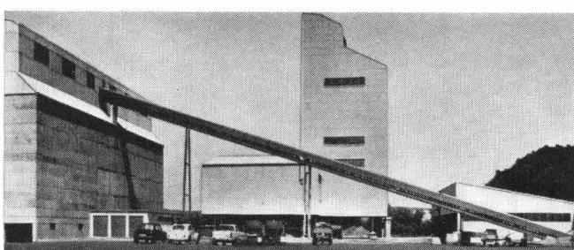
Über ein Transportband von 80 m Länge kann stündlich 600 m<sup>3</sup> Material von der Entladegosse (Bahn- und Autobeschickung) in die Siloanlage transportiert werden.
