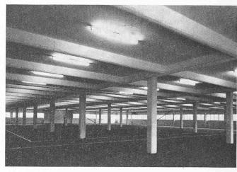
Bild 3. Fertige Lagerhausdecke. In diesem Fall wurden die Unterflanschen noch mit einem Asbestspraybelag versehen, wodurch eine Brandsicherheit von F 90 erreicht wird
