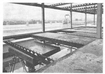
Bild 2. Einfahren der Schalung zwischen die asymmetrischen Waben-
