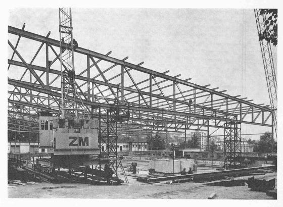
Bild 1. Fachwerk-Zusammenbau
