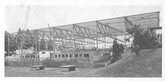
Schrauben verbinden zu können, da im Obergurt die grossen Druckkräfte durch Kontakt übertragen werden und nur die Pfostenkräfte durch Schrauben zu verbinden sind, während im Untergurt nur die Horizontalkomponenten der Diagonalkräfte angeschlossen werden müssen. Die Untergurtteile selbst wurden auf der Baustelle über Stumpfnähte verschweisst.
