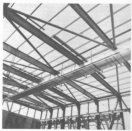
Bild 2. Teilansicht der Hallenrahmen mit Dachverband
