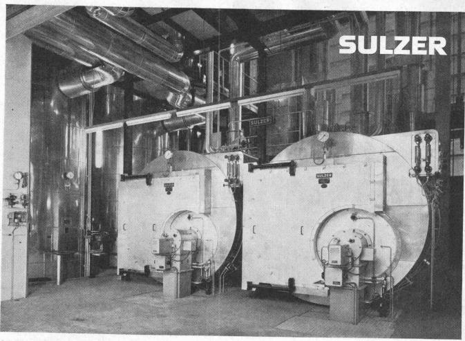
2 Sulzer-Dreizugkessel mit automatischer Ölfeuerung in einer chemischen Fabrik. Leistung je Kessel 12,8 bis 16 t/h Sattdampf, Betriebsdruck 12 atü.
