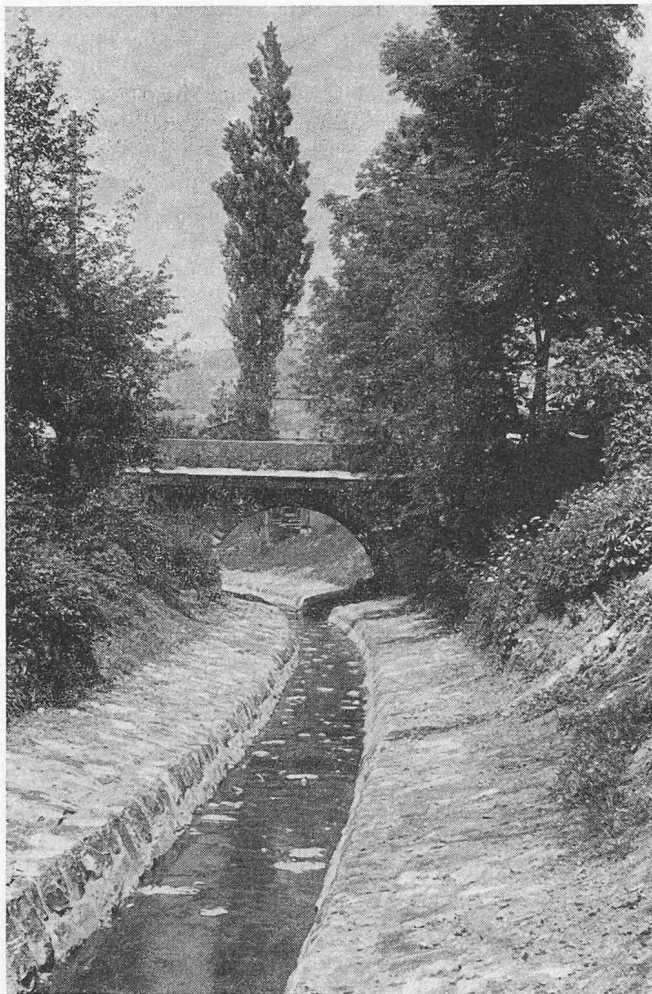
Bild 3. Der im Zuge der Rheinebene-Melioration korrigierte Altstätter Stadtbach: Früher ein unansehnliches Rinnsal, eine Abfallgrube, heute ein unter Schonung des alten Baumbestandes korrigierter, sauberer Bach
