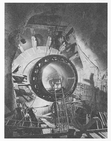
Bild 7. Montage der Rückstromdrossel im Kaunertalkraftwerk
