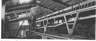
Aebi/von Roll-Verteilförderbänder beschicken bei Vorwahl automatisch die entsprechenden Silozellen.
