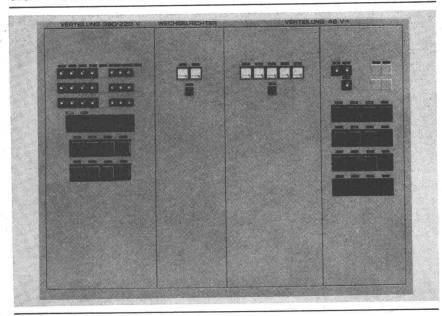
Betriebssicherheit und Wirtschaftlichkeit sind die wichtigsten Anforderungen an Notstromanlagen im Wechselstromnetz. An Stelle der früher eingesetzten Benzin- oder Diesel-Aggregate werden mehr und mehr statische Wechselrichter kombiniert mit Batterien als sofort verfügbare und zuverlässige Energiereserve verwendet. Der convertomat-Wechselrichter garantiert bei Netzausfall eine unterbruchlose Stromversorgung.
