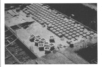
Vermietung von ausschalbaren Kunstharzschalungen für die Konstruktion von Kassettendecken mit gekreuzten Rippen, und von Relief-Verschalungselementen für Granit-Imitation von Betonmauern. Normierte Grössen. Spezialfabrikation auf Bestel-
