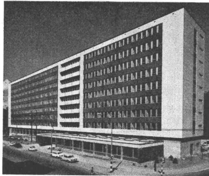
Das Verwaltungsgebäude der Oberösterreichischen Krankenkasse Linz ist ein typisches Beispiel moderner, zweckmässiger Bau-Denkweise. Bei der architektonischen Planung dieses repräsentativen Geschäftshauses wurde auch an unverwüstliche Ablaufinstallationen gedacht.
