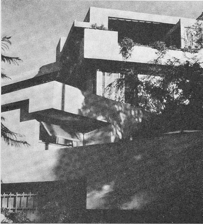
Ansicht von der Strasse
