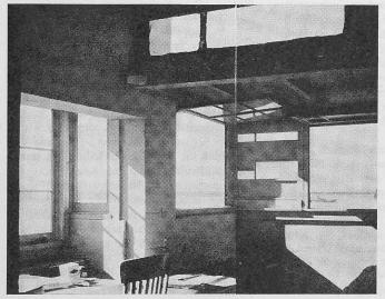
Eingangsseite. Der Bau ruht auf fünf durchgehenden Betonrahmenträgern
