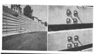
Verankerung von Beton-Elementen in Bohrpfählen mit Felsanker AREFIX.
