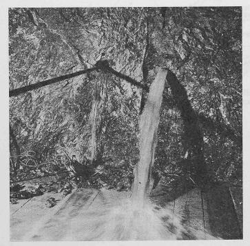
Die Intensität des Wasserandranges geht parallel mit der Intensität der Klüfte. Besonders die grossen Hauptklüfte mit ihrer zerriebenen, lose gelagerten und nicht verkitteten Füllung dienen als Wasserträger. Wird eine solche Kluft angeschlagen, so entleert sie sich unter gleichzeitiger Ausschwemmung des zerriebenen Materiales (Bilder 3, 4, 13).
