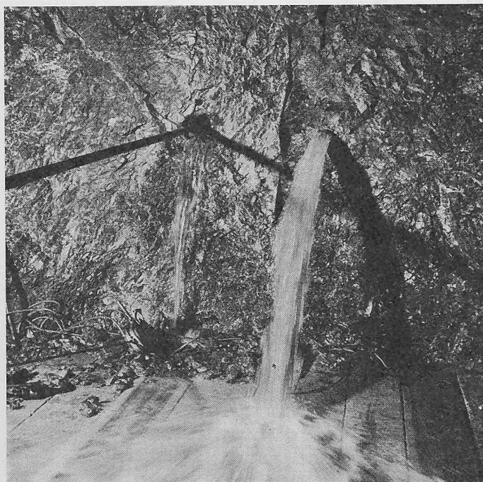
Bild 3. Vom standfesten Fels aus angebohrte wasserführende Kluft
