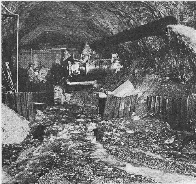
Bild 13. Druckstollen Sampuoir. Situation im Stollen nach dem Materialeinbruch aus der Kluft bei Stollenmeter 1492.50. Eine Betonmauer wird vor dem zugeschütteten Bagger Conway 100 erstellt. Wasserandrang 130 l/sec
