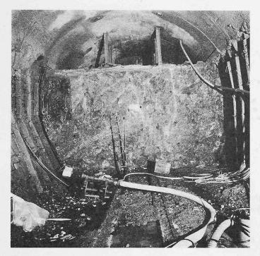
Bild 11. Druckstollen Sampuoir. Ausbruch des unteren Profilteiles beim Durchfahren der konsolidierten Kluft bei Stollenmeter 306
