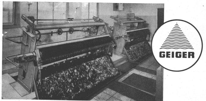
RECHEN- UND SIEBANLAGEN ZUR BRAUCHWASSERREINIGUNG
