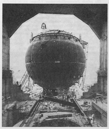
das Druckabbausystem und die Zwangsumlaufkreise aufnehmen. Um die Bauzeit zu verkürzen, wurden der Sicherheitsbehälter und das Reaktorgebäude räumlich getrennt und gleichzeitig gebaut. Dadurch konnten acht Monate Bauzeit eingespart werden. Nach der Fertigstellung beider Teile wurde der Behälter auf Schienen mittels hydraulischer Pressen in das Gebäude hineingezogen (Bild 1). Diese Arbeit nahm rund zehn Tage in Anspruch.
