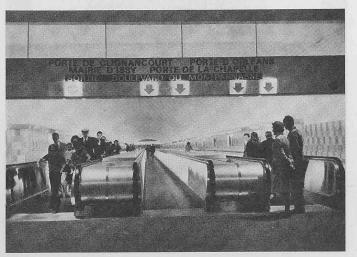
kehrsstrom die Personenbänder in der einen oder anderen Richtung gefahren werden, Bild 1. Jedes Band hat eine Breite von 1200 mm und fördert bei einer Geschwindigkeit von 50 m/min bis zu 12 000 Personen/h. Mit solchen Anlagen können Steigungen bis zu 12° überwunden werden.
