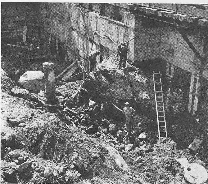
Blick in die Baugrube mit Findlingen bis zu rund 25 m<sup>3</sup>. Diese mussten hydraulisch gesprengt werden. Die noch verbleibenden Hindernisse zwangen zu einer Änderung der Baugrubensicherung durch Bohrfähle mit Eisenbeton-Aufschaltung
